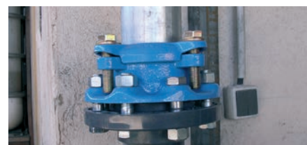
MISE EN PLACE ENTERRÉE
