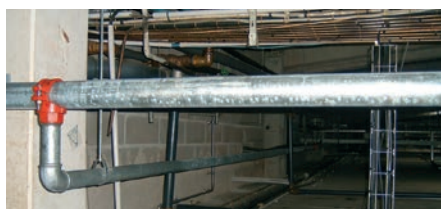
MISE EN PLACE EN COMBLE
